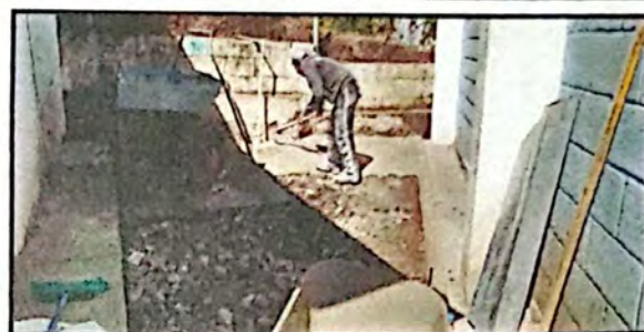
Foto 12: Reparacion de patio
