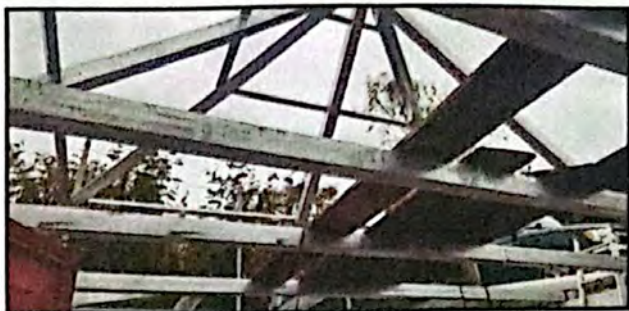
Foto 1: Instalando soporte de metal
