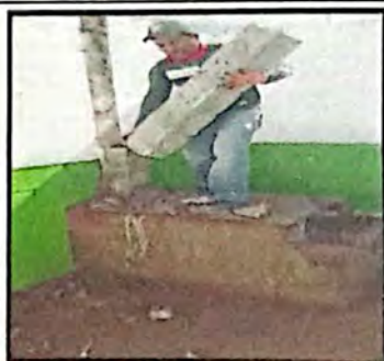
Foto 5: Reparacion de planchas
