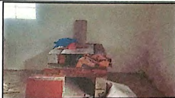
Foto 6: Colocando azulejo en planchas
