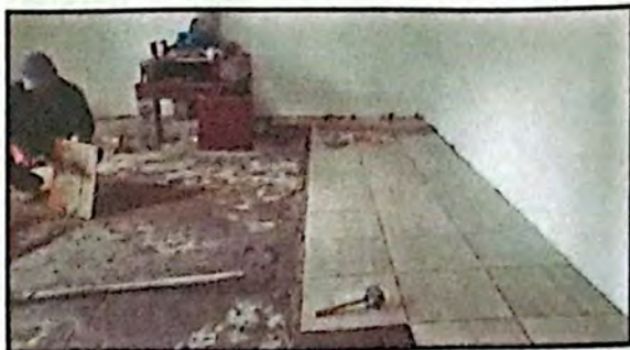
Foto 7: Colocando piso ceramico
